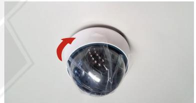
Beim Einrasten verschiebt sich die Blickrichtung ein wenig mit der Drehung. Sie können die Kamera bei Bedarf vorher ein wenig zurückdrehen, damit die Blickrichtung nach dem Einrasten stimmt.
